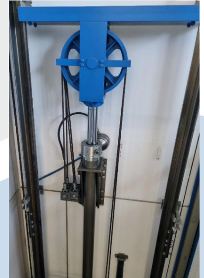
İzolatorlular binalara hidrolik silindir montajı.
